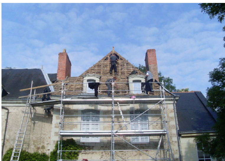
Emmanuel Raffray et Marc Gérard à l'oeuvre sur le toit d'une maison ancienne
